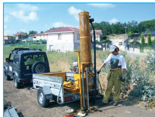
[Figura 1].- Ensayo de penetración tipo borro (Guadalix de la Sierra, Madrid, 2006)
