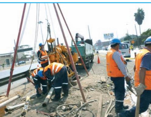
[Fig. 7].- equipo de sondeos en convencional sin la unidad de golpeo (SPT) integrada. Lima, Perú (cortesía Luis Taricuarima).
