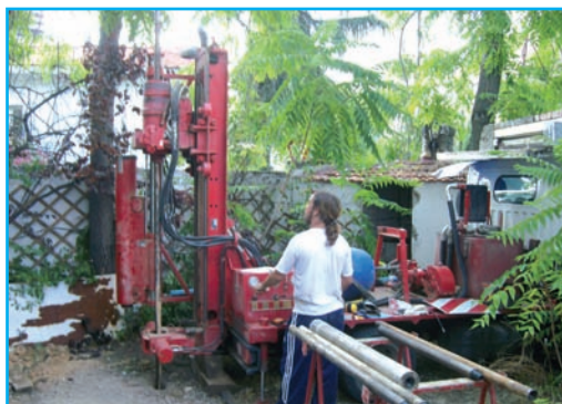
[Fig. 6].- Sondeo convencional con ensayos de penetración dinámica - toma de muestra SPT e inalterada (El Viso, Madrid, 2008). Nótese a la izquierda de la torre de sondeo, la unidad de golpeo.
