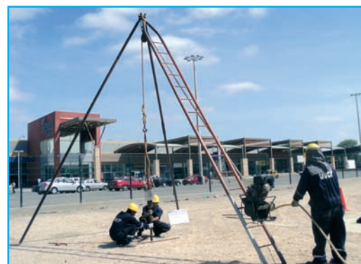
[Figura 2].- Ensayo de penetración dinámica superpesada "cono peck" (cortesía Univ. de Piura).
